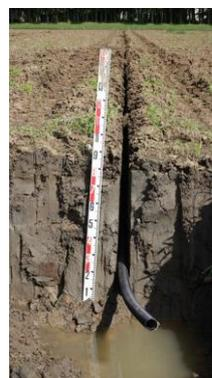
【カットドレーン(左図)を応用した本暗渠施工機化の試作機による施工状況(右図)】
